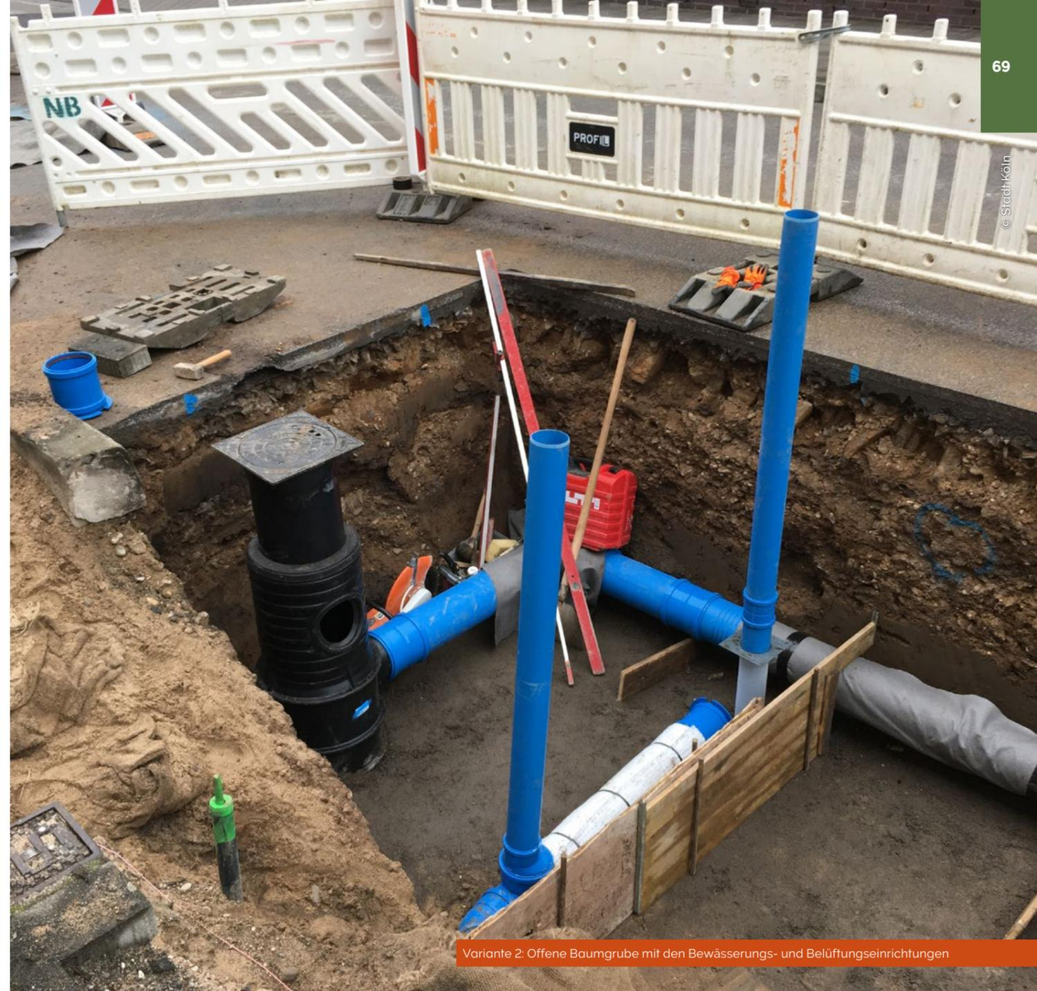
Variante 2: Offene Baumgrube mit den Bewässerungs- und Belüftungseinrichtungen
